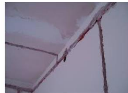
Remont starego domu: wymiana instalacji ... ladnydom.pl
