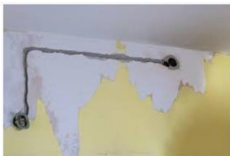
Instalacja elektryczna w starym domu ... dom.wp.pl
