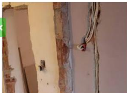
Remont starej instalacji elektrycznej budujemydom.pl
