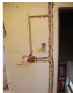
Remont starej instalacji ... budujemydom.pl
